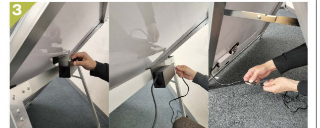
3 アダプターホルダーをフレームに引っ掛け、アダプターを収納し、コントローラーと繋げて完了です。
